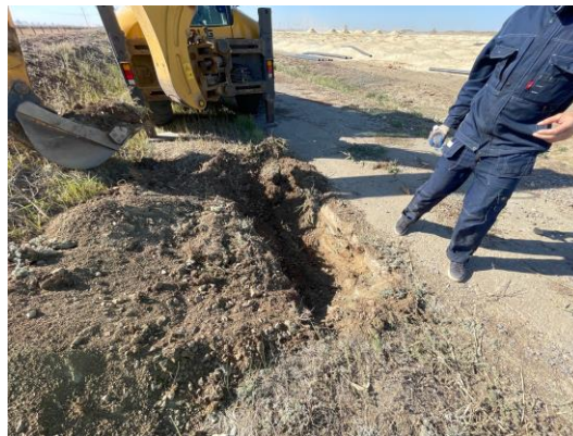
Фото Б.28 - Общий вид вскрытия шурфа
