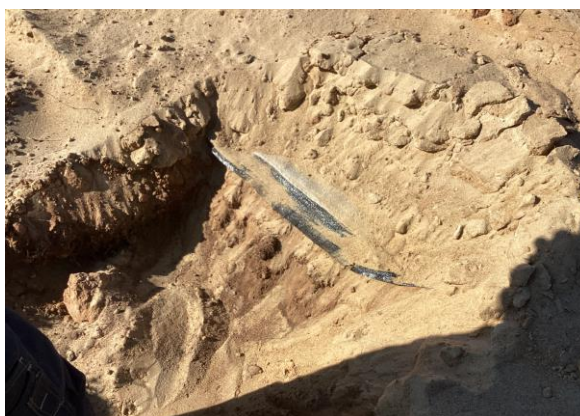
Фото Б.3 - Вскрытие шурфа (Шурф №1) до гидроизолирующего слоя
