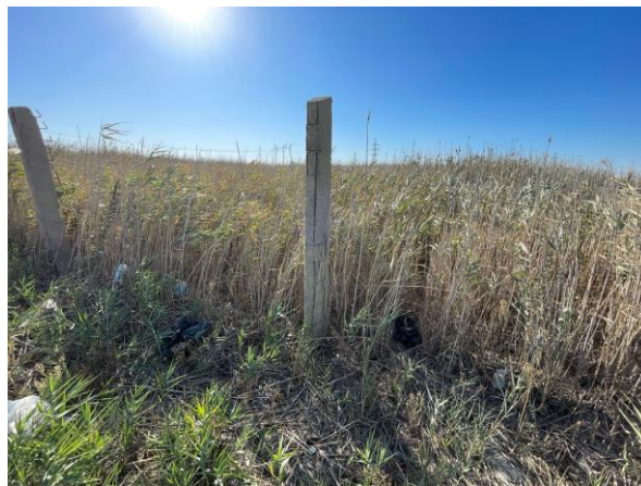
Фото Б.18 - Общий вид ограждений (железобетонных) в западной части полигона
