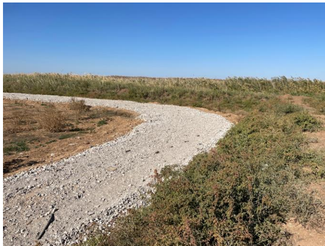
Фото Б.24 - Общий вид дороги (северо-восточная часть полигона)
