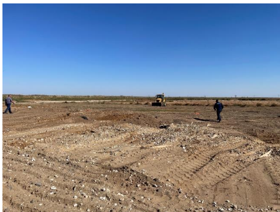
Фото Б.1 - Общий вид неэксплуатируемой части полигона (восточная часть)
