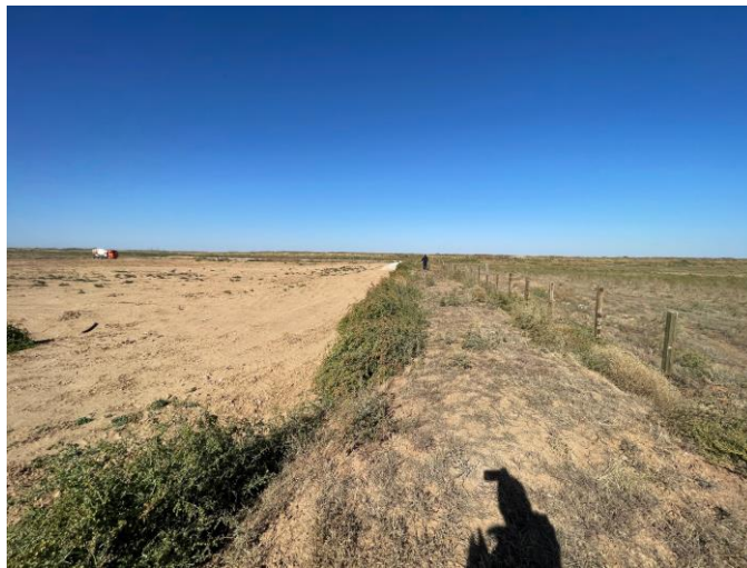
Фото Б.13 - Общий вид обваловки (восточная часть полигона)
