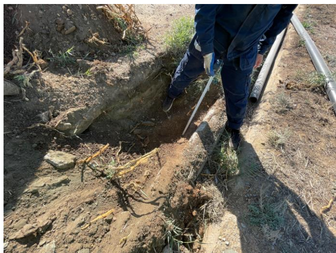
Фото Б.8 - Общий вид вскрытия шурфа на участке устройства бетонных лотков
