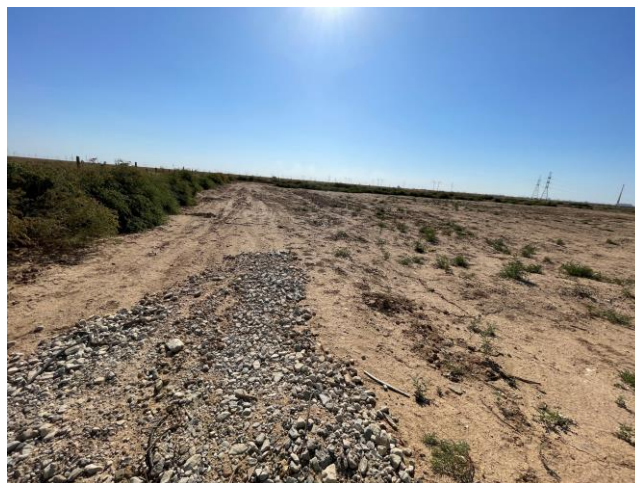
Фото Б.25 - Общий вид дороги (восточная часть полигона)
