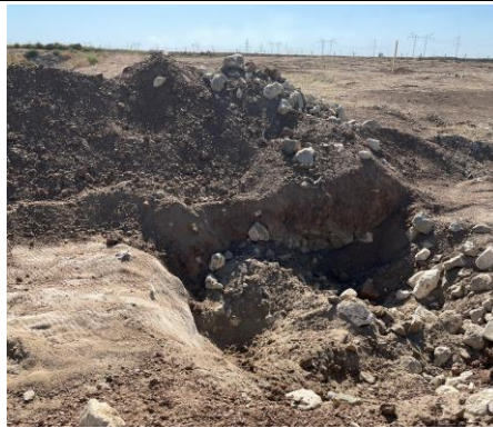
Фото Б.4 - Вскрытие шурфа (Шурф №2) до гидроизолирующего слоя
