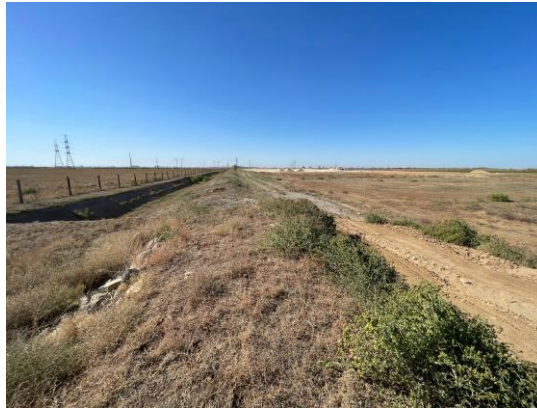
Фото Б.27 - Общий вид дороги (южная часть полигона)
