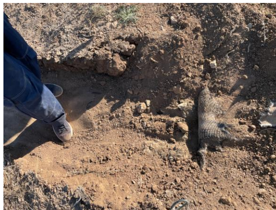
Фото Б.5 - Вскрытие шурфа (Шурф №3) до гидроизолирующего слоя
