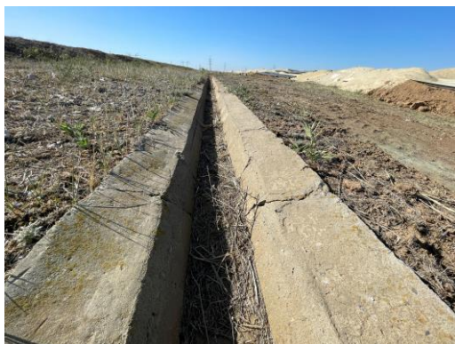
Фото Б.6 - Общий вид бетонных лотков
