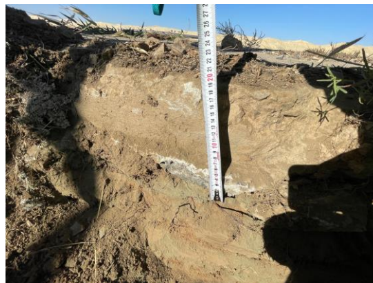
Фото Б.30 - Определение толщины дорожного покрытия
